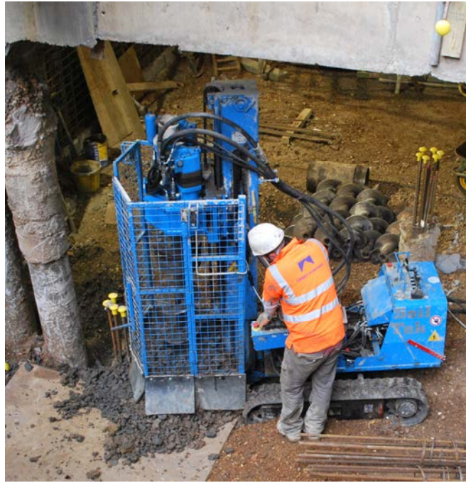
Figure 14. Restricted access mini piling rig
